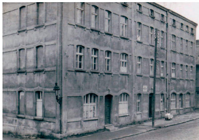
Budynek starej powojennej przychodni
